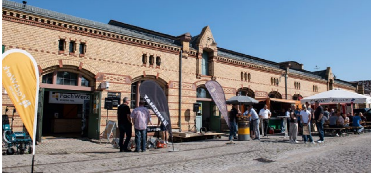
FachWerk Werkzeug-Pohl sitzt in einer denkmalgeschützten, ehemaligen Viehbörse.
